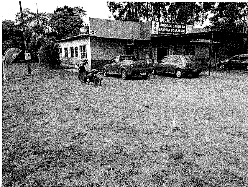
Fotografia 01 – Fachada frontal, inexistência de vaga reservada.
